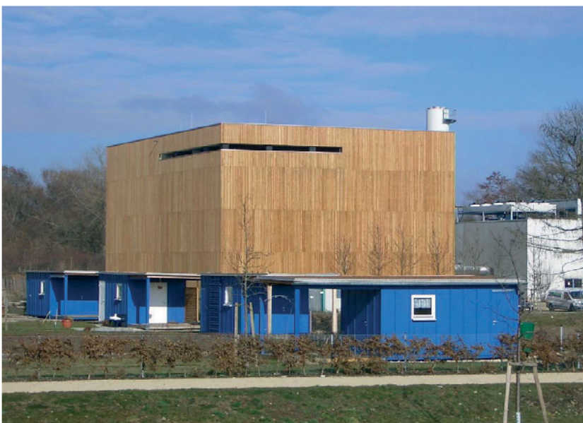
Abb.: Holzheizkraftwerk Scharhauser Park (Betreiber: Stadtwerke Esslingen)
